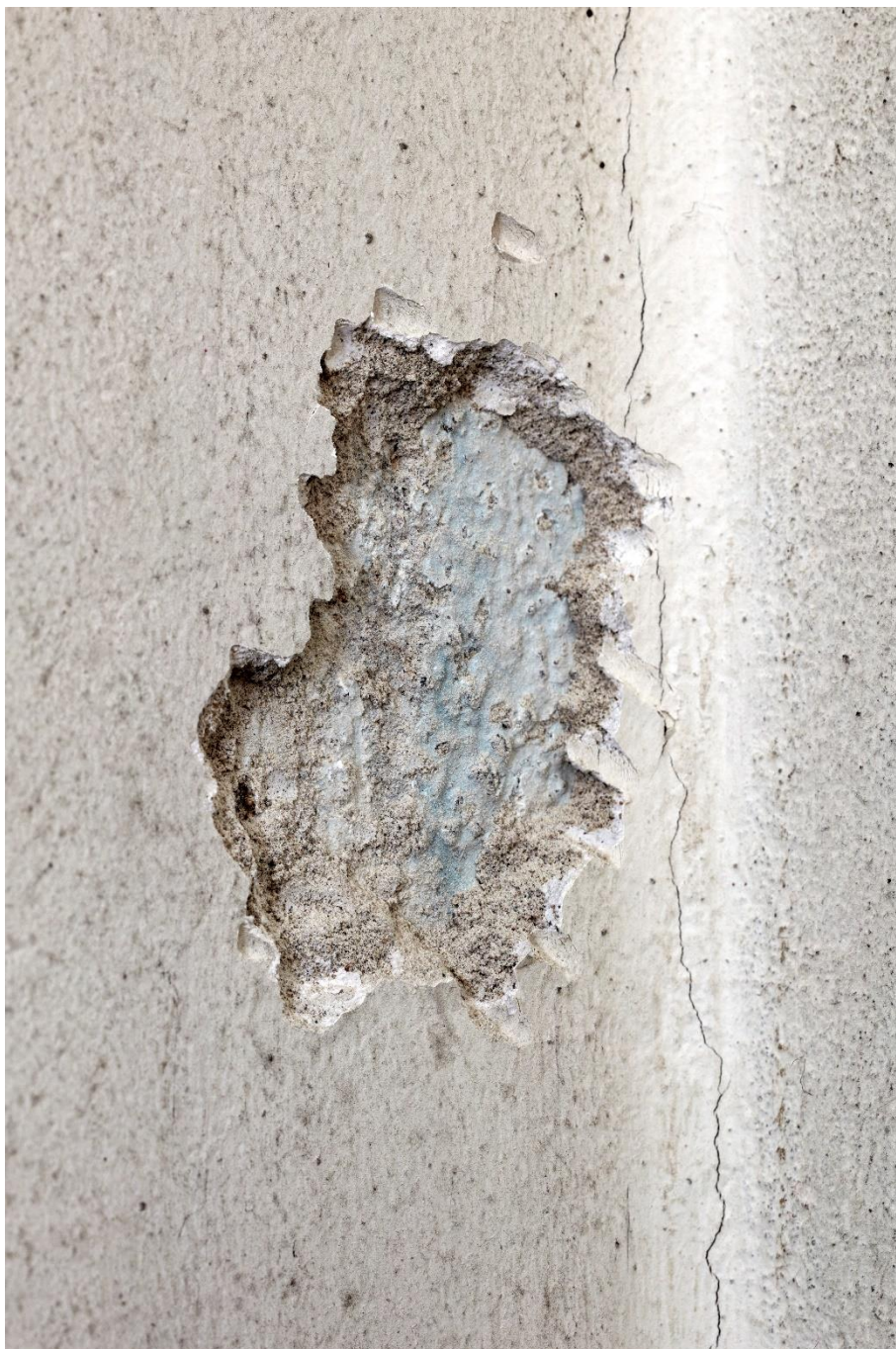
Fot. 21. Odkrywka nr 12 w sąsiedztwie łuku oddzielającego empore od nawy. Tynk z wyraźną fakturą oraz warstwą malarską w odcieniu szaroniebieskim. Kolor sprawia wrażenie intensywniejszego niż zaobserwowany we wcześniejszych odkrywkach, co może być wynikiem przebarwienia czy płowienia (niewykluczone, że zastosowano nietrwałe, syntetyczne pigmenty). Nie można także wykluczyć, że intensywność koloru zróżnicowano.
