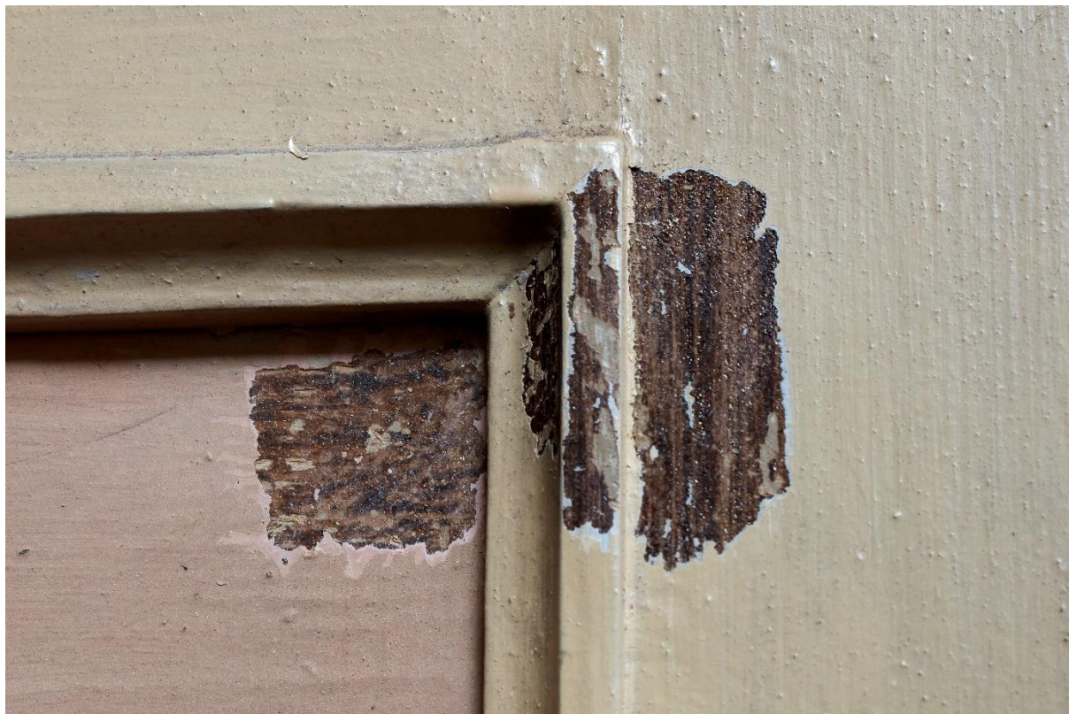
Fot. 24. Fragment balustrady empyry. Mazerunek w kolorze ciemnobrązowym.
