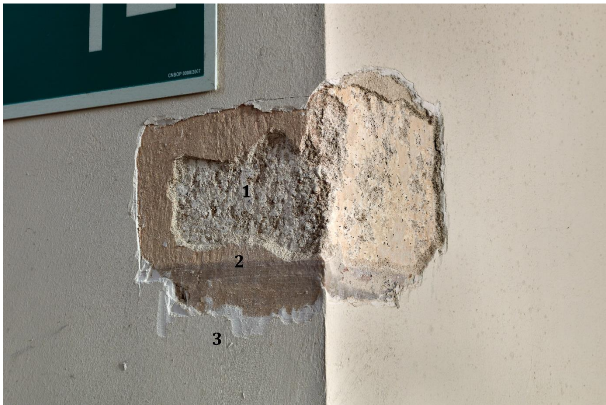
Fot. 15. Odkrywka nr 7 na narożniku filaru przylegającego do bocznej ściany południowo-wschodniej w sąsiedztwie prezbiterium. Pod kolejnymi warstwami tynku widoczny najstarszy o głębokiej fakturze (1). Kolejne warstwy tynku były zagładzane jednorodnie na wszystkich powierzchniach (2). Skontrastowane walorowo opracowanie dwustrefowe wskazuje, iż jest element opracowania widocznego na fotografii z 1957 roku (na s. 6, fot. 1).
