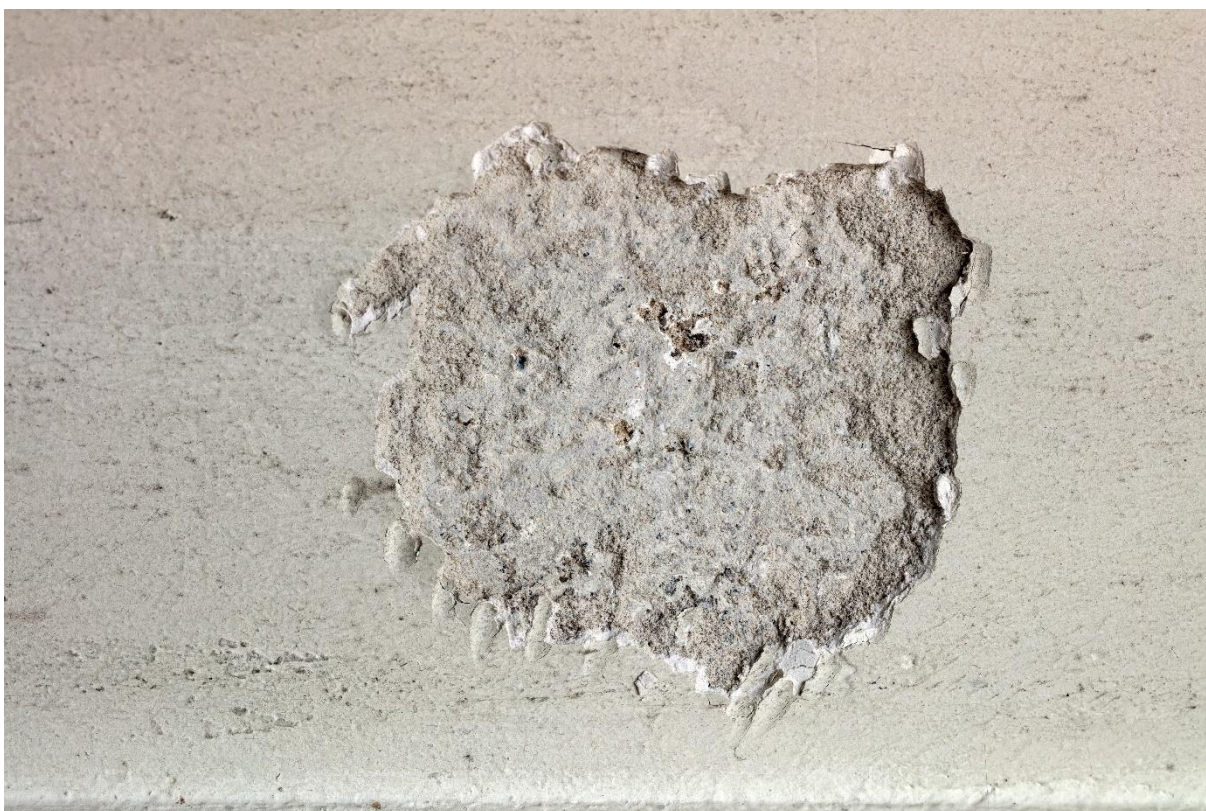
Fot. 20. Odkrywka nr 11 w narożniku po przeciwnej stronie (pomiędzy ścianą północno-zachodnią, oraz północno-wschodnią – po północnej stronie empory). Faktura tynku oraz kolorystyka analogiczne do zaobserwowanych w pozostałych odkrywkach.
