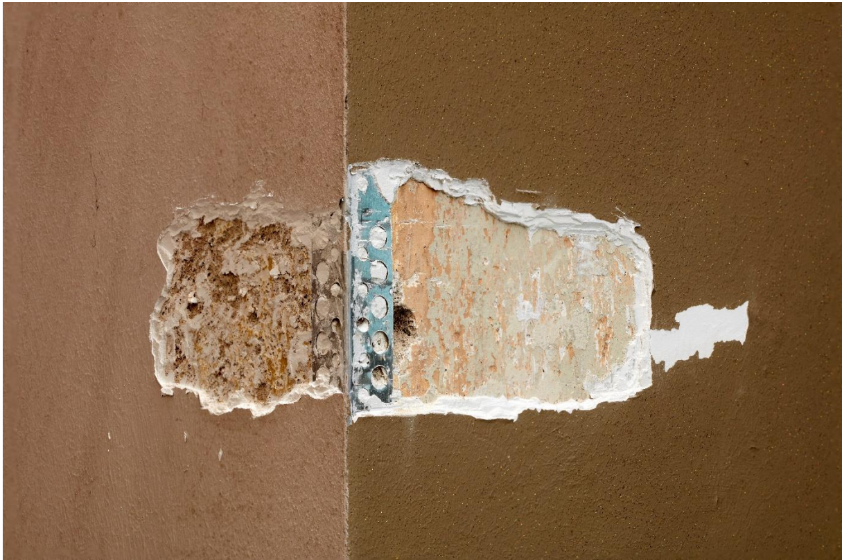
Fot. 5. Odkrywka nr 1 na krawędzi łuku tęczowego. Podczas ostatniego remontu powierzchnię ścian prezbiterium pokryto grubą warstwą szpachli gipsowej, w której zatopiono aluminiowe narożniki. Wewnętrzną powierzchnię łuku tęczowego pomalowano farbą z dodatkiem brokatu. Powłoka sprawia wrażenie zwięzłej, co może wskazywać na zastosowanie tzw. farby lateksowej, a więc dyspersyjnej o większym udziale spoiwa, co wpływa na łatwą zmywalność. Pod warstwą gipsu zaobserwowano warstwy malarskie w kolorze beżowym oraz starszą, w kolorze pomarańczowym (ugrowym). Na bocznej ścianie (po lewej stronie zdjęcia) najstarsza warstwa ma kolor ciemnougrowy.
