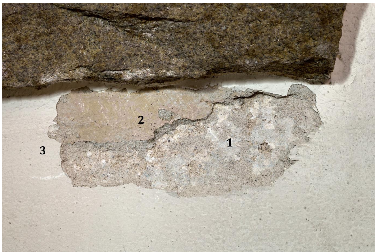
Fot. 12. Odkrywka nr 4 na ścianie północno-wschodniej poniżej dekoracyjnej okładziny kamiennej (w przeszłości na ścianach bocznych namalowane były stacje Drogi krzyżowej). Najstarszy tynk miał głęboką fakturę oraz powłokę malarską w kolorze szaroniebieskim położoną na pobiałe (1). Kolejna warstwa tynku miała powierzchnię zagładzoną oraz opracowanie malarskie w kolorze beżowym (2). Najmłodsza chronologicznie warstwa to zagładzony tynk i opracowanie w kolorze białym (3).
