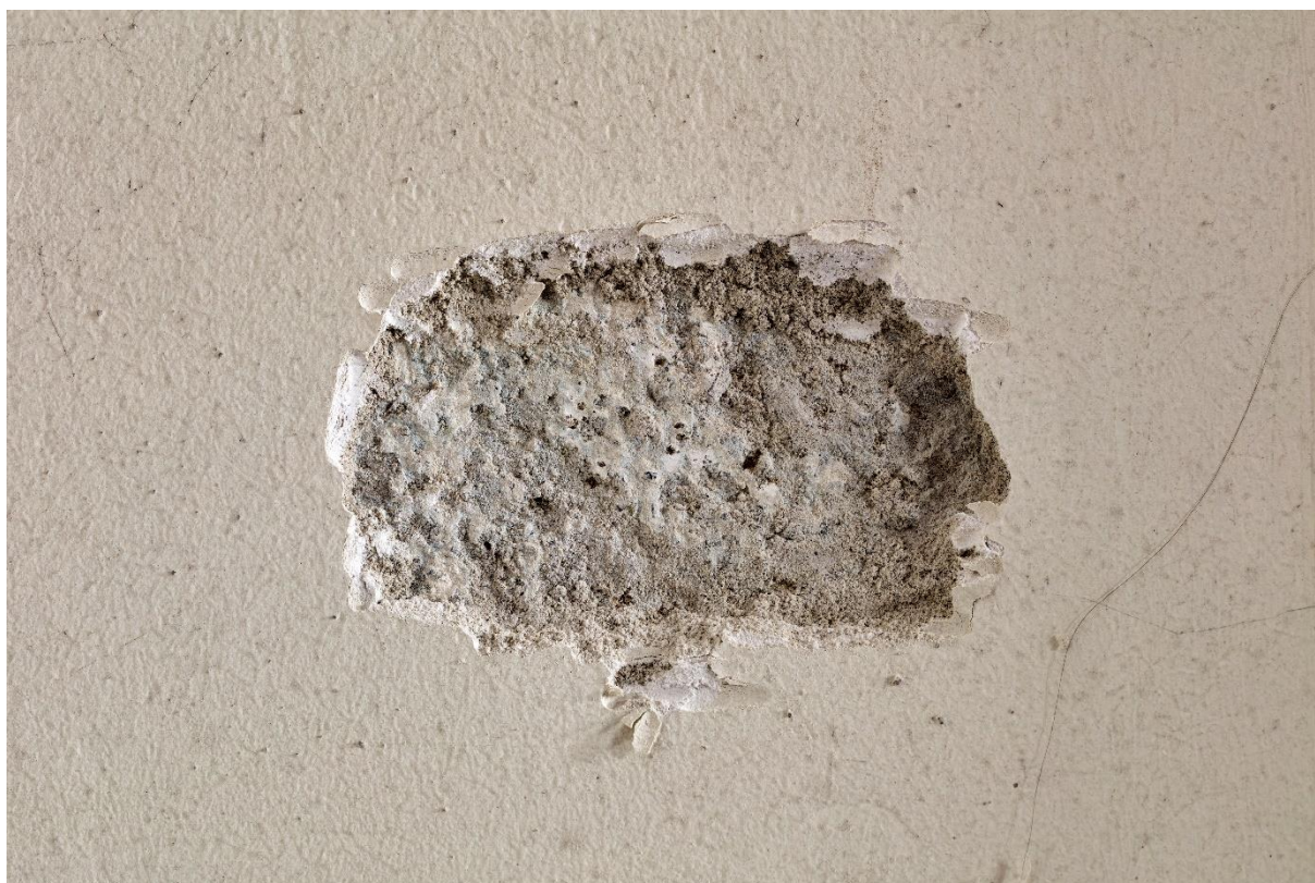
Fot. 14. Odkrywka nr 6 na ścianie południowo-wschodniej po lewej stronie łuku tęczowego (w sąsiedztwie drzwi). Oryginalny tynk ma głęboką fakturę (typową dla wypraw z lat 20. i 30. XX w.)
