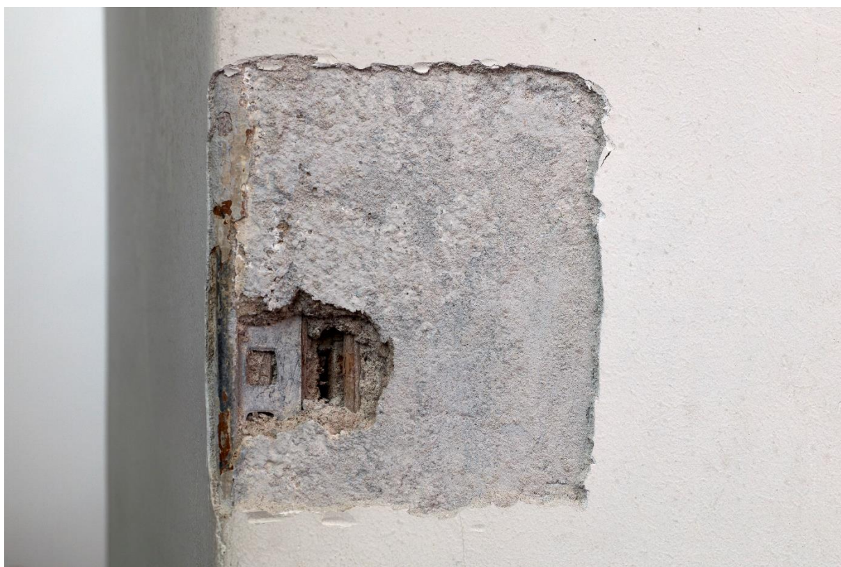
Fot. 18. Odkrywka nr 9 na krawędzi filaru – pod współczesnym, zagładzonym tykiem wyprawa pierwotna. Filary wykonano z drewna, krawędzie ze stalowych kątowników, całość otynkowano na trzcinowej macie. Warstwa malarska na pierwotnym tynku ma odcień szaroniebieski. Tynk ma nieco płytszą fakturę niż ten, którym pokryto pierwotnie ściany.
