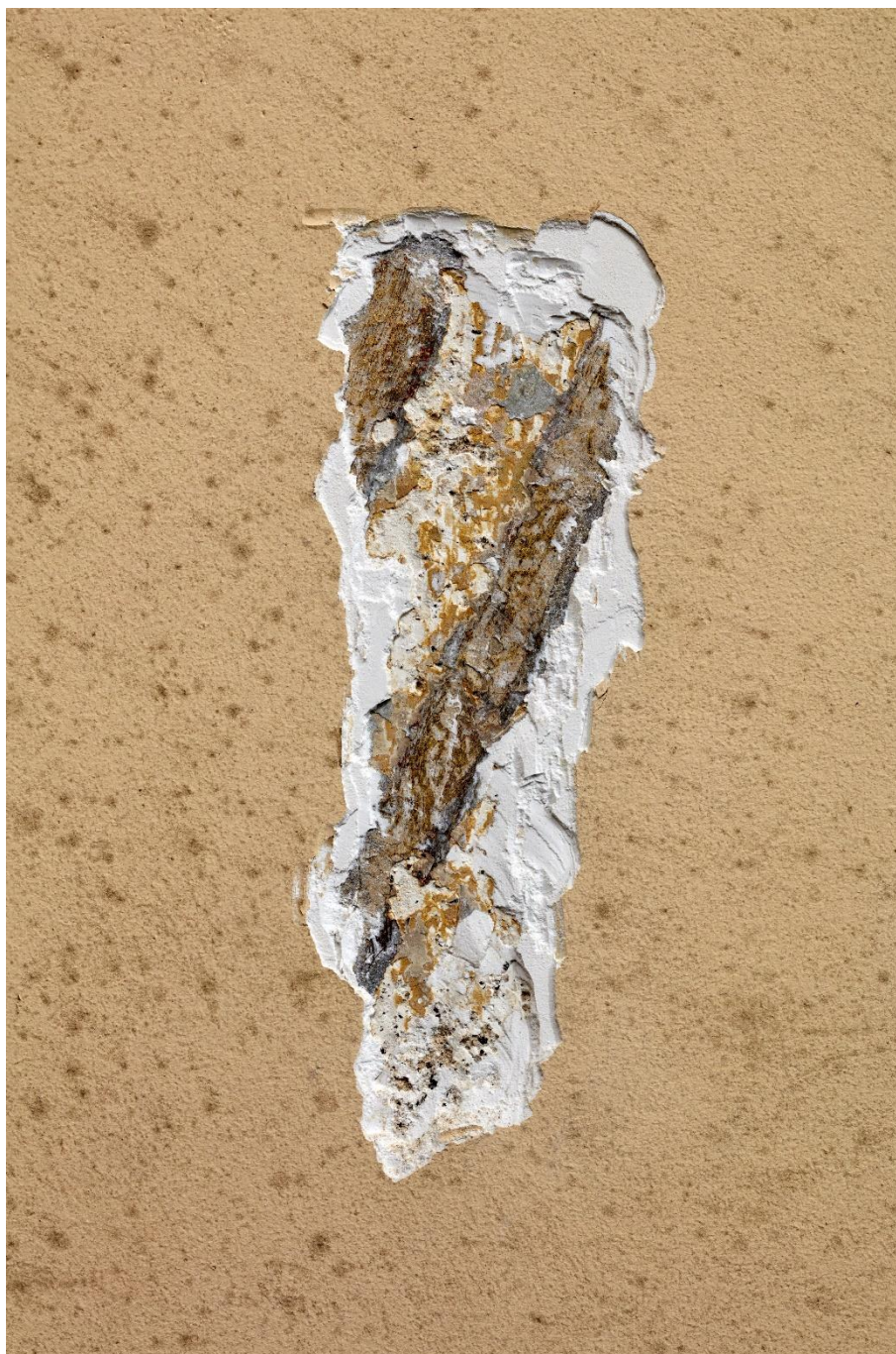
Fot. 9. Odkrywka nr 3 na ścianie zamykającej prezbiterium. Pod gipsową szpachlą fragment polichromii z pozłotą – być może krawędź szaty Apostoła.
